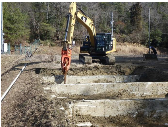
基礎撤去の状況(令和 3 年 2 月)
