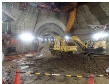
(主立坑深度 500m 接続部)
